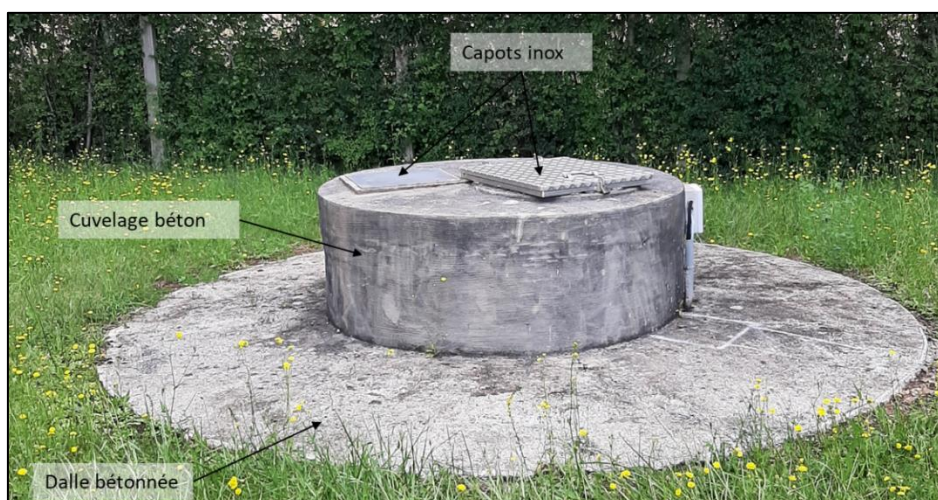
Figure 15 : Tête du forage F3
