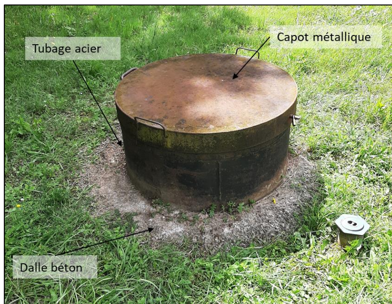
Figure 16 : Tête du forage F5
