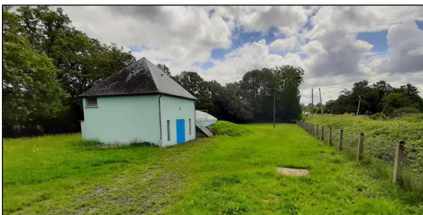
Figure 14 : Station de reprise et de la clôture sur le site de production Sacierges 2
